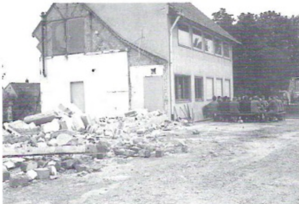
Abbruch der alten Turnhalle
