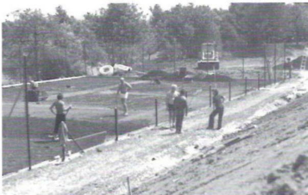
Bauarbeiten im Frühjahr 1981
